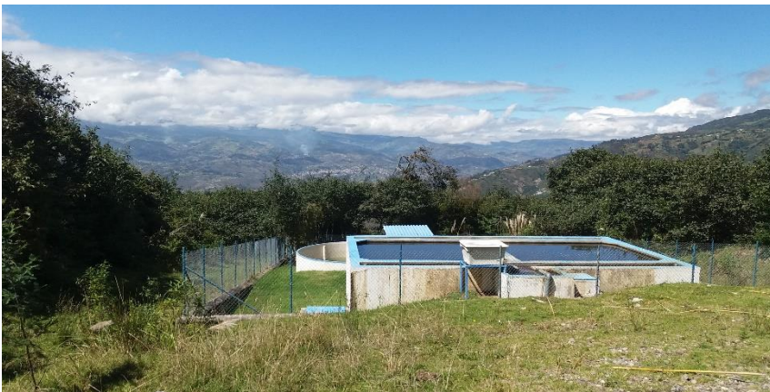
Imagen 9. Planta de Agua Potable
