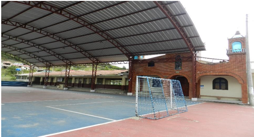
Imagen 13. Escuela 26 de Febrero Tacapamba
